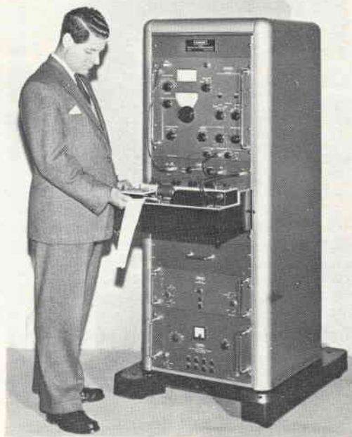
Un ingegnere esamina la registrazione di un'analisi di vibrazione prodotta dall'analizzatore d'onda e registratore automatico K-100, della Muirhead.
